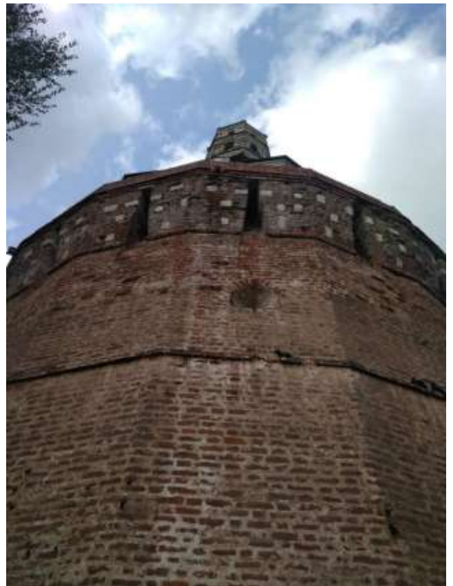
Башня «Дуло», архитектор Федор Конь
